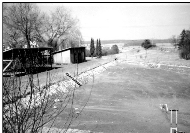
Fotografie z roku 1993 - tehdy se začalo s bouráním typických kabin a zahájila se první větší přestavba. Dokončena byla v roce 1994, i s výstavbou nového zázemí, které známe dnes.
