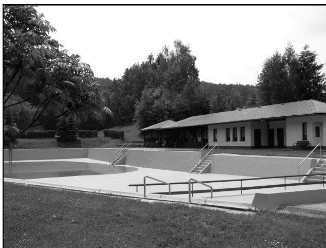
Současná tvář koupaliště. Po rozsáhlé opravě nádrže, která proběhla v roce 2009 a 2010. Současně s tím byla vyměněna střecha na budově zázemí poškozená vandaly na jaře 2009.
