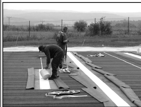
Pracovníci firmy Sibera Systém provádějí pokládku umělého koberce
