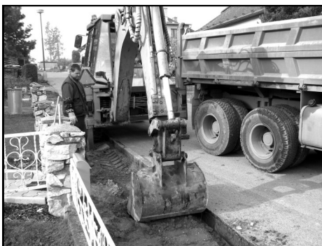
V rámci dotace Lázeňského mikroregionu probíhá rekonstrukce chodníku v ulici V Sadě
